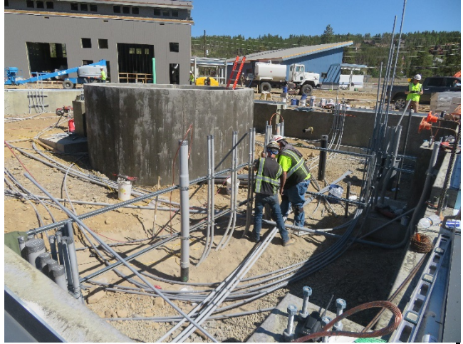
8/26/2019 – Residuals PEMB Below Grade Conduits
